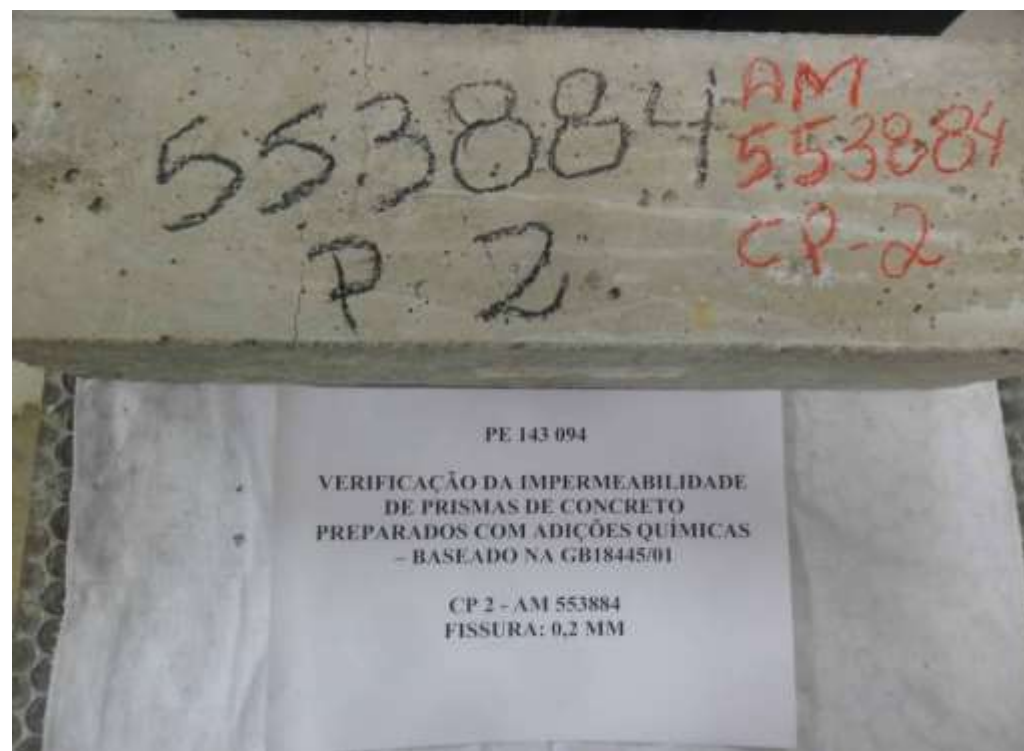
CP 2 Muestra 553884 – Fisura 0,2 mm
